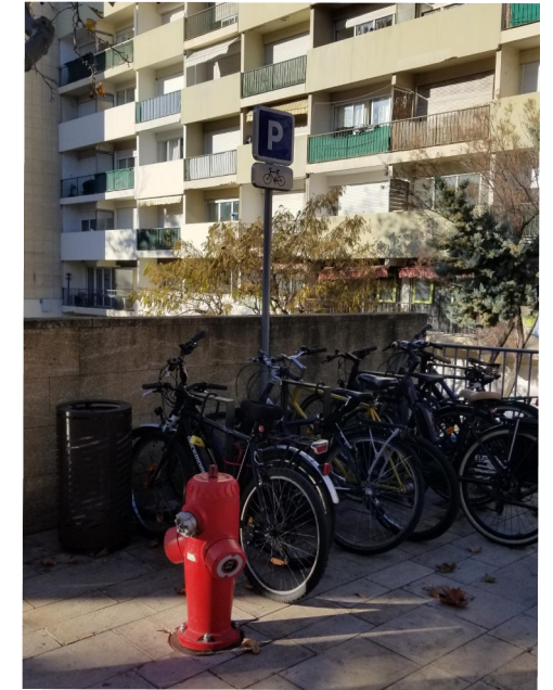
Une borne à incendie
